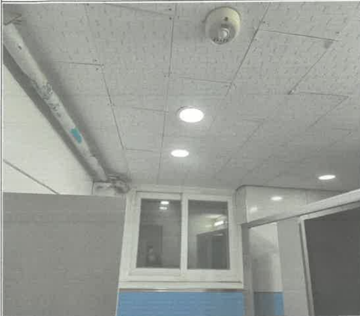
지하 1층 남자 화장실 천장 다운라이트 점등 불량 1개소 교체
