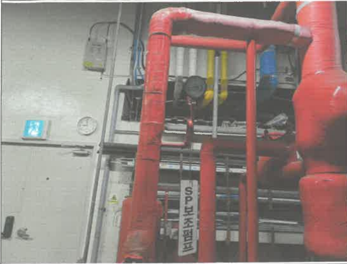
기계실 스프링클러 보조 펌프 상단 압력계 교체
