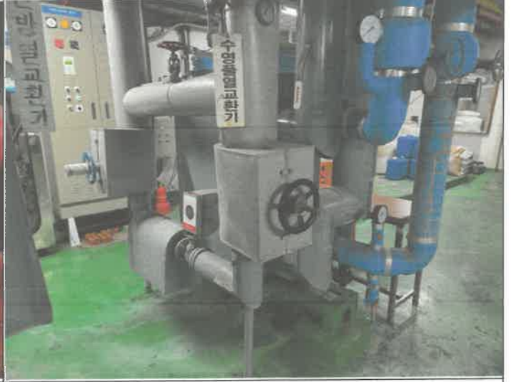
수영장 수온 조절 열교환기 1차측 밸브 스프링들 누수 해체 조치 조립
