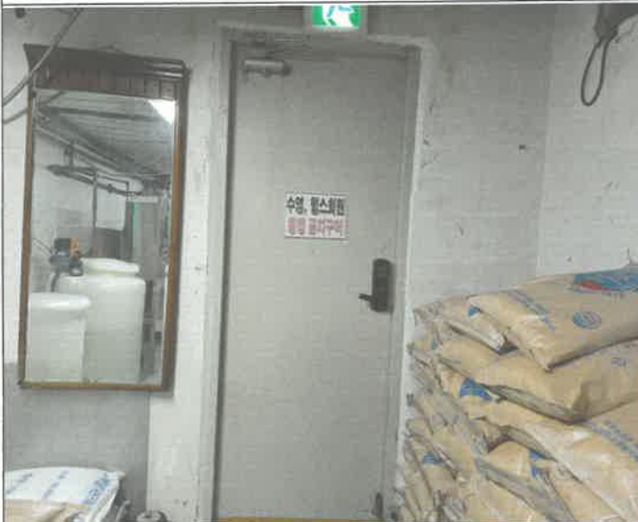
기계실 수영장 쪽 출입문 도어 클로저 탈거 되어 제설치
