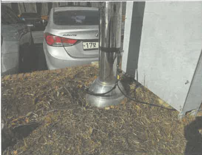
주차장 CCTV카메라 재 결선
