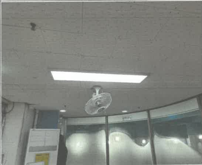
수영장 로비 천장 매립등 점등 불량 1개소 교체
