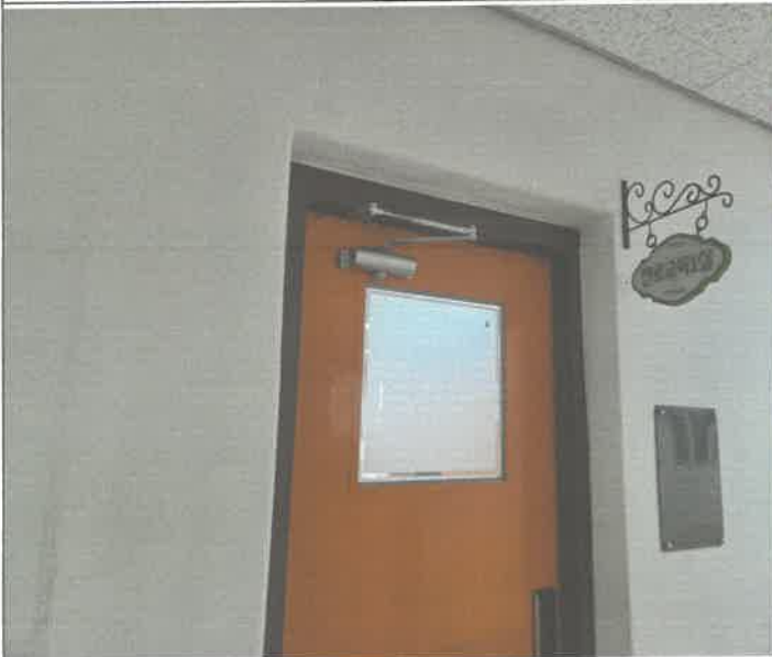
3층 진로 1실 출입문 도어 클로저 교체
