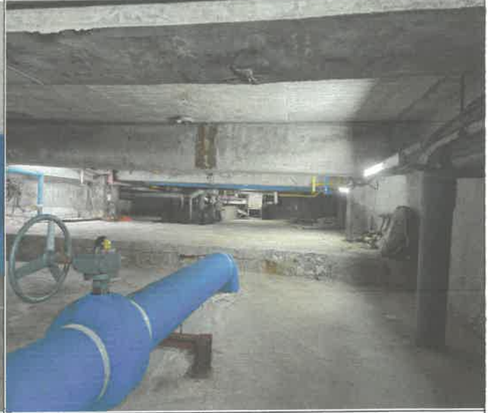
지하 비트 배수 배관 이음부 누수 임시 보수
