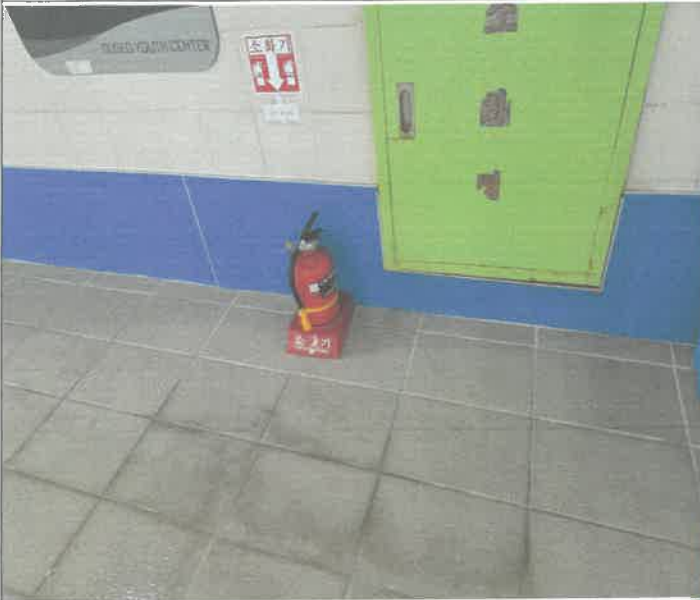
수영장 내부 소화기 가스 압력 미달로 교체
