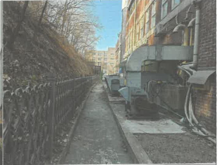
건물 후면 각종 배기팬 점검 및 구리스 주입
