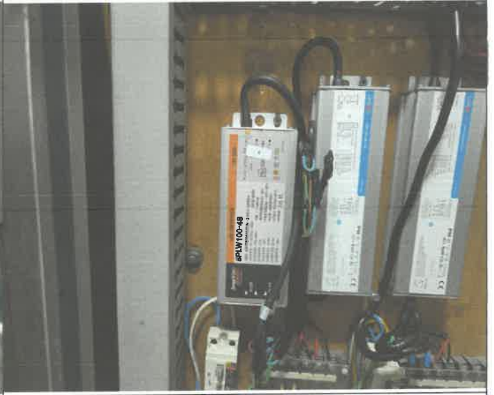
수영장 내 등 1개소 점등 불량 안전기 교체
