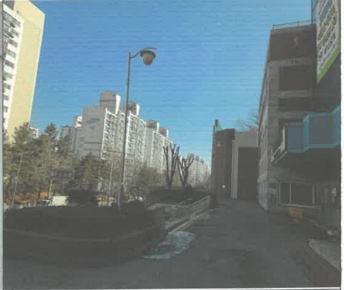
1층 주 출입구 돌계단 2개소 가로등 등 교체
