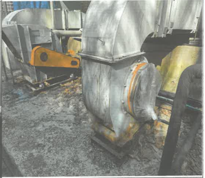
1층 청소년 극장 공조 배기 인입수 봉합
